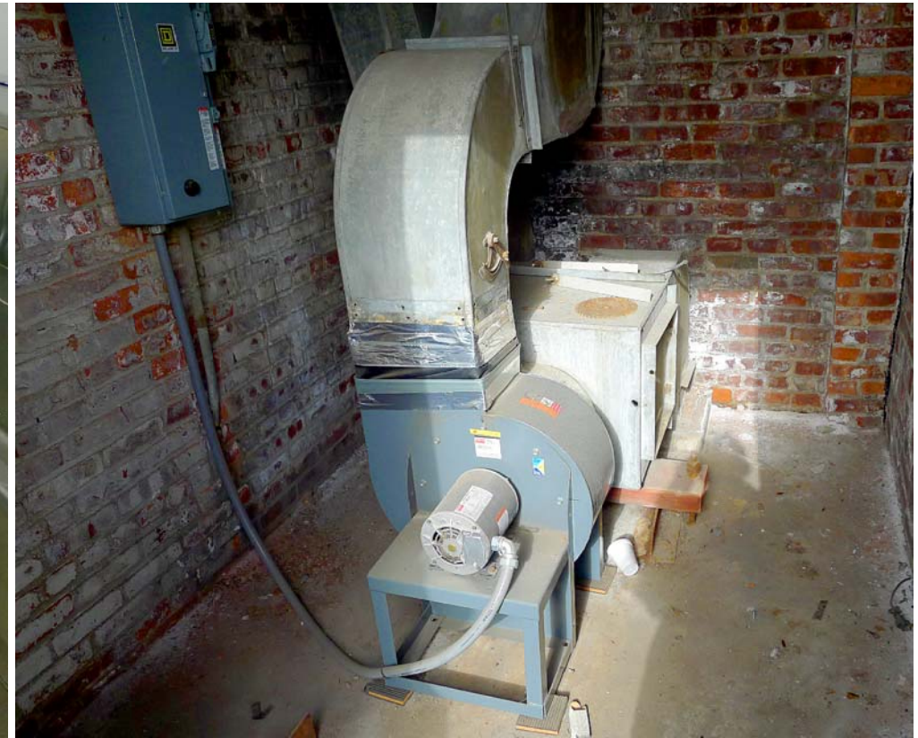
22 EF - Exhaust Fan ROOM LOCATION :
