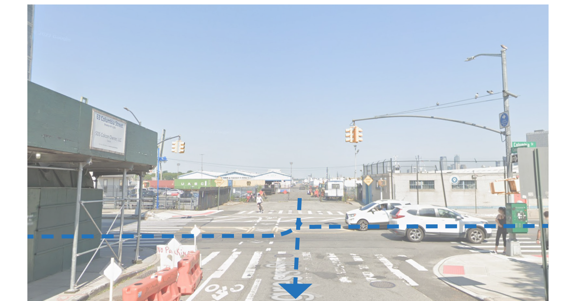
目前停用闸口
