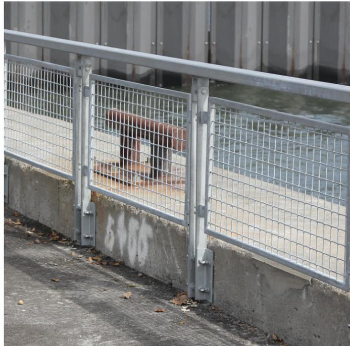
GUARDRAIL - 42" HT. GALVANIZED W.W.M. AND STEEL TUBE RAIL
